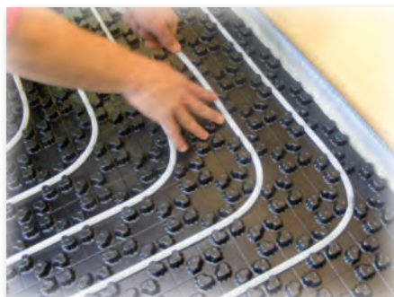
Incastrare il tubo Pe-xa da Ø 10 mm tra le nocche del pannello
