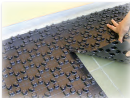
La sovrapposizione dei pannelli sui due lati è facilitata grazie alla tecnica push button che consente una posa rapida e precisa.
