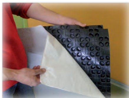
Rimuovere la pellicola di protezione sul retro del pannello Ultraslim prima della posa a terra.
