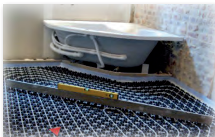
Segnare il punto più alto del pavimento esistente come punto di controllo per il minimo spessore di copertura prima di posare il massetto premiscelato.
