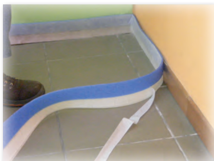
Fissare la fascia perimetrale attraverso il foglio adesivo lungo le pareti, le colonne e i gradini.
