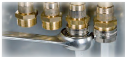
Collegare le tubazioni. Fare un lavaggio ed effettuare la prova in pressione.
